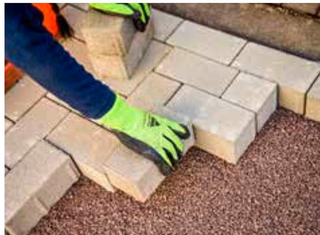
Konzentriert wird Stein für Stein auf eine Splittbettung verlegt und mit dem Hammer festgesetzt.
