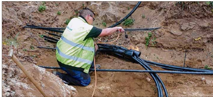
Robin Meinhardt von der Firma Omexom fügt im Industriepark neuen Leitungen zusammen. Fotos (2): Elke Schütze/Mario Kraus
